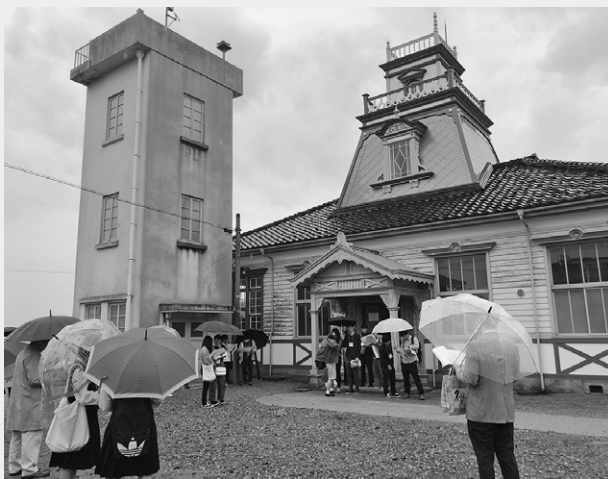
塔屋が復元改修された伏木測候所
